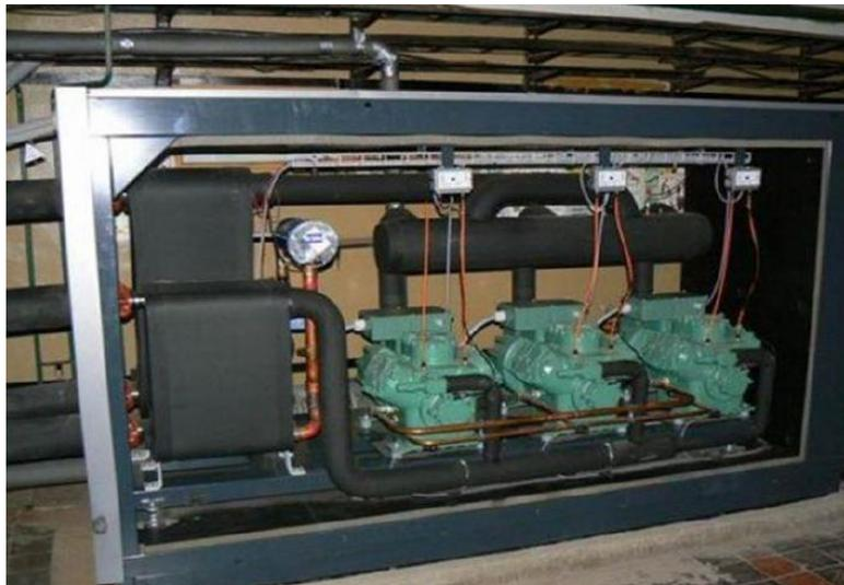
Тепловые насосы заменили электроротельную, где было установлено шесть котлов совокупной тепловой мощностью 960 кВт.
